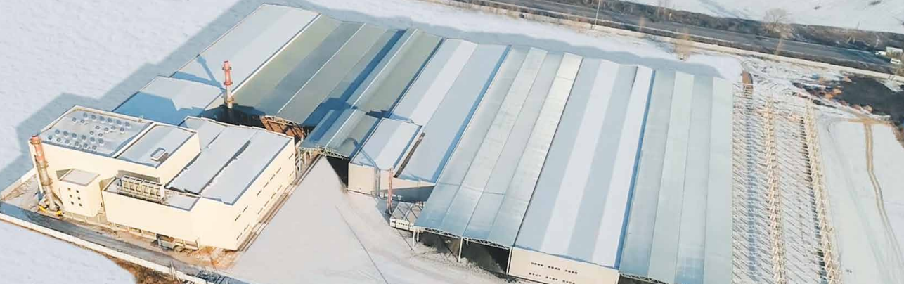
РОССИЯ, ВОРОНЕЖ. Производство: минераловатные плиты, стеновые и кровельные сэндвич-панели
